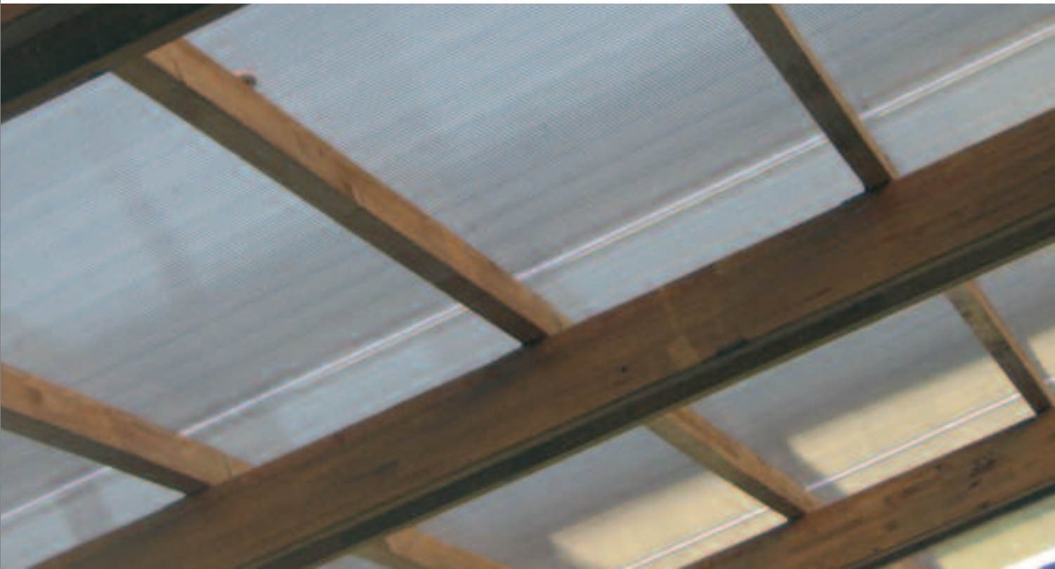
Particolare della copertura con lexan.
