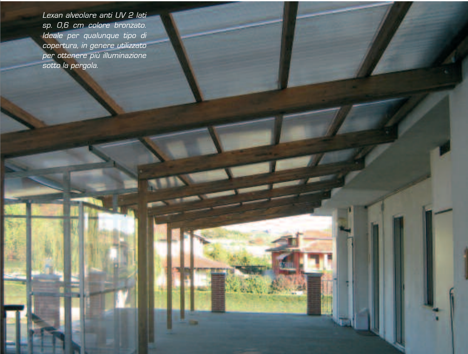
Particolare della copertura con lexan.
