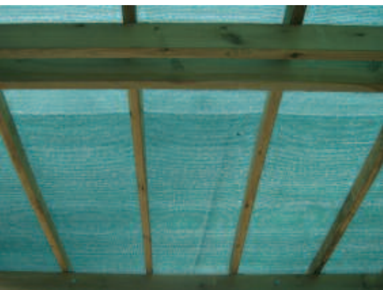
Particolari della copertura con ombreggiante.
